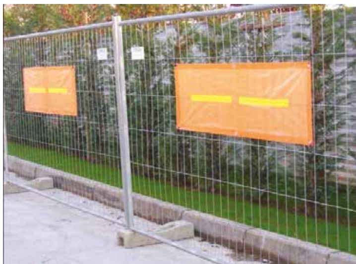
Recinzione provvisoria per cantieri edili
